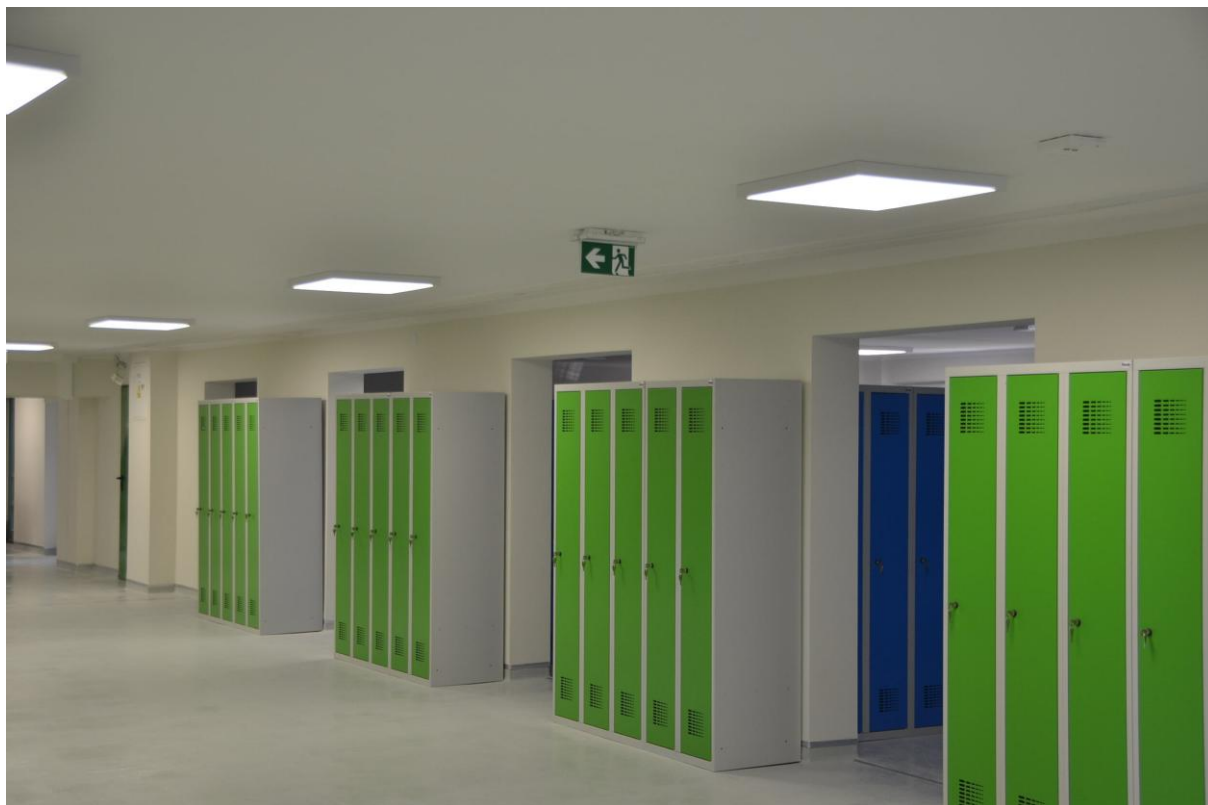
Przebudowa szatni w Szkole Podstawowej w Starych Babicach
