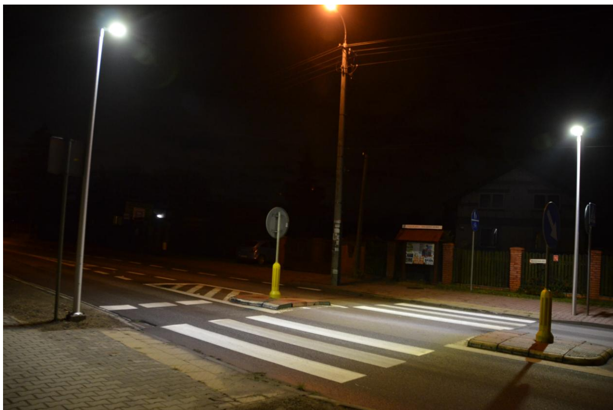
Doświetlenie przejścia dla pieszych w Koczargach Nowe, przy posesji 419
