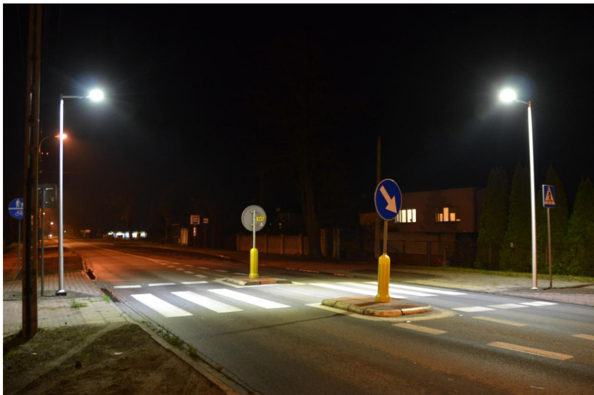
Doświetlenie przejścia dla pieszych przy posesji nr 732 w Wojcieszynie
