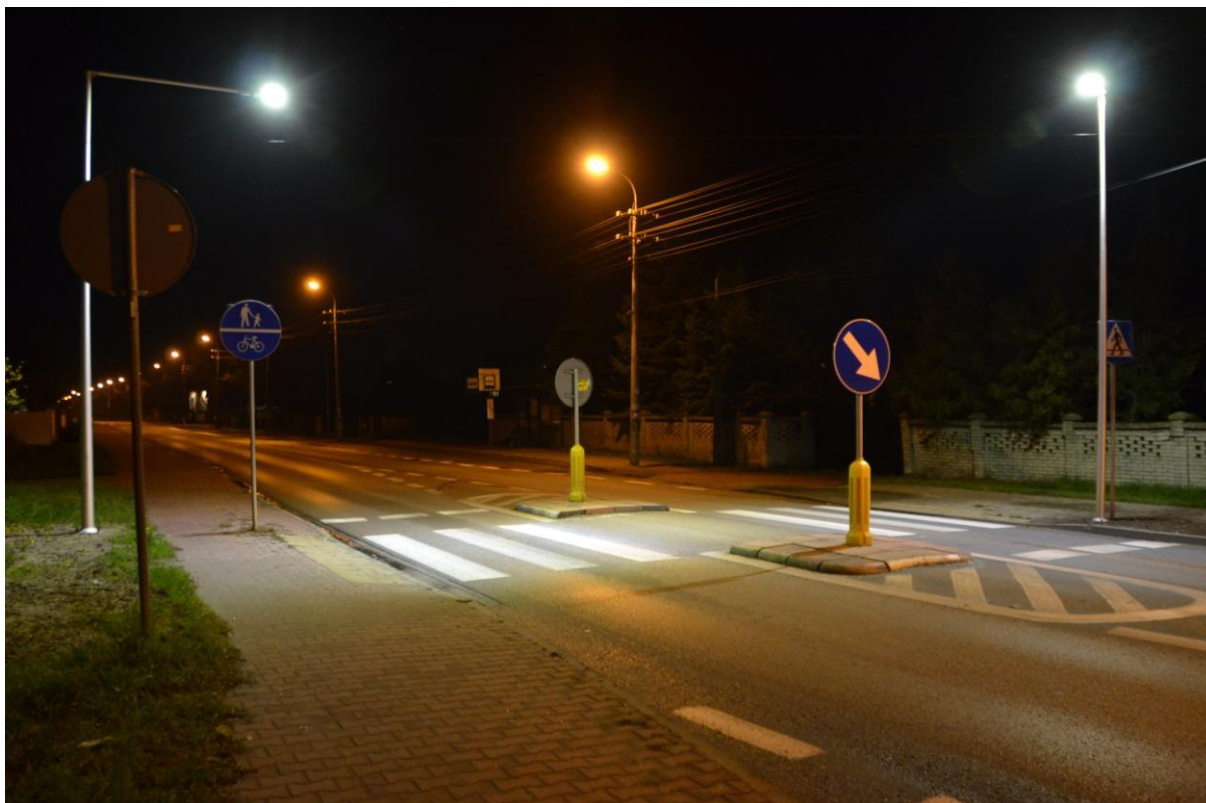
Doświetlenie przejścia dla pieszych Zielonki-Wieś
